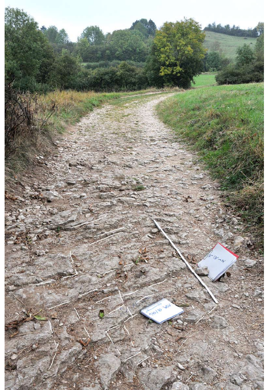
Abb. 16: Entlang des Weges vom Walberla zum Rodenstein sind die zwischen den Massenfazies-Kuppeln erhaltenen Kalksteine angeschnitten. In ihnen zeichnet sich die engständige Klüftung in der Aufsicht deutlich ab. Die beiden Hauptrichtungen 170/80 WSW (parallel zur Längskante des Blocks) und 130/+90 (parallel zum Zollstock) – dies entspricht auch den statistischen Maxima wie dem Verlauf der Flanken des Berges, die durch Felsabstürze an diesen Klüften zurück versetzt wurden und weiter auch werden. Weitere, dazu parallele Trennflächen sind mit weißen Linien markiert.
