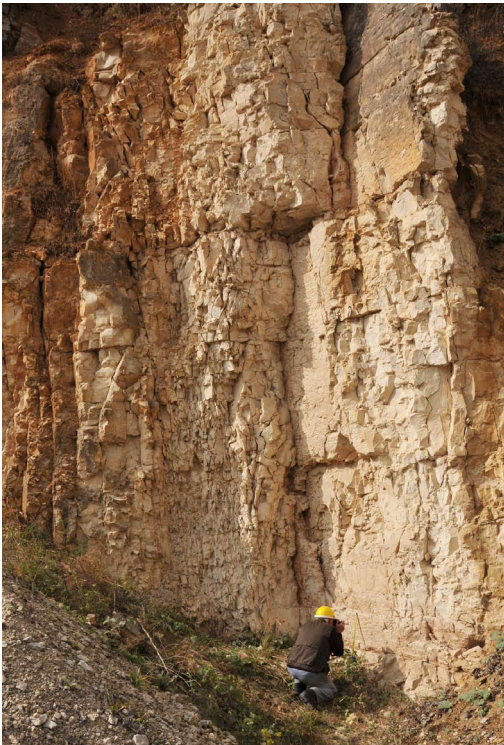
Abb. 4: Ausschnitt aus der Südwand des Steinbruchs Pongratz (Wolfsbach). Die Engständigkeit der weitgehend vertikalen Klüfte erzeugt zusammen mit der Schichtung ein stark zerrüttetes Gefügebild. Die freigestellte Fläche unmittelbar hinter der Figur ist die Messfläche 1, deren Lagerung im Diagramm Abb. 5 gesondert eingetragen ist sowie in Detailansicht (Abb. 6.) diskutiert wird.
